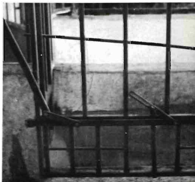
Fig. 9.—Detalle de los elementos de sujeción del comedero.
