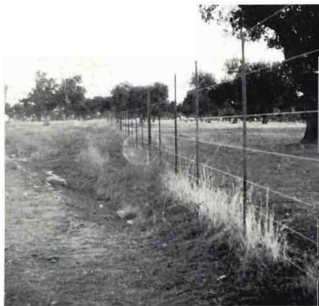
Fig. 6.—Valla de alambre liso montado sobre postes metálicos.
