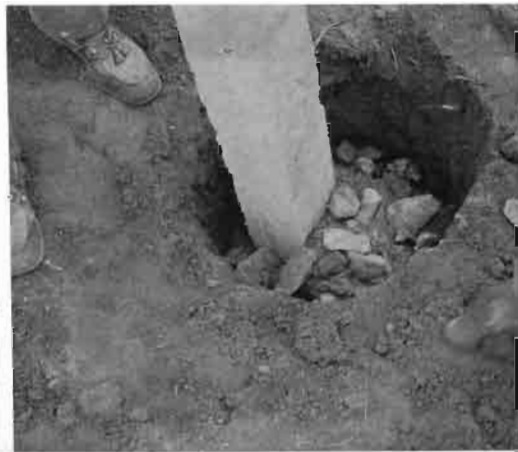
Fig. 7.—Instalación de postes. Detalles del uso del nivel para lograr verticalidad y del anclaje mediante hormigón.
