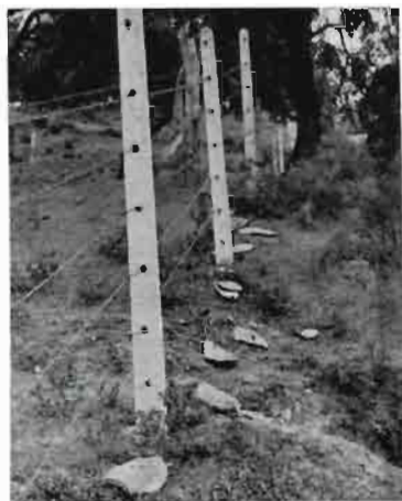
Fig. 13.—Dos ejemplos de cercas de alambre de espino. Apréciase cómo los alambres están sujetos por ataduras al poste de hormigón y por grapas a los de madera.
