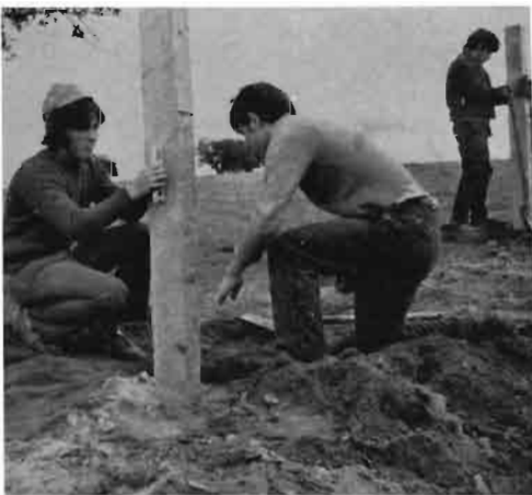
Fig. 7.—Instalación de postes. Detalles del uso del nivel para lograr verticalidad y del anclaje mediante hormigón.
