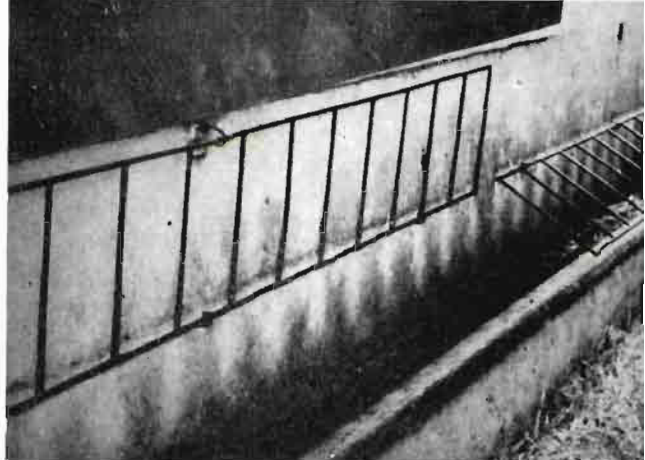
Fig. 7. —La parte inferior de este comedero está formada por un canal de fibrocemento. En él se sirven los forrajes y piensos compuestos.
