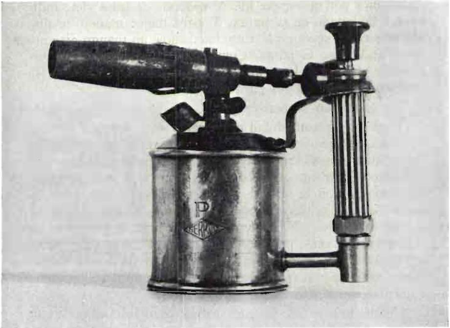
Fig. 3.—Soplete de gasolina que puede utilizarse como aparato calentador.
