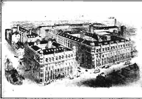
Las dependencias centrales de la Wholesale de Manchester ocupan varias manzanas.
