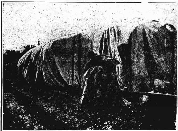
Obrero entrando en una tienda con el generador de ácido cianhídrico. En segundo término: medición con la cinta del perímetro de otra tienda.
