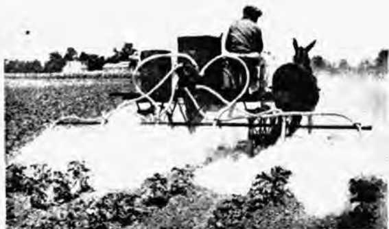
Fig. 43.—Espolvoreador de carro aplicable a las plantaciones de algodónero y otros cultivos en línea; cubre de seis a ocho líneas de plantas en cada pase.
