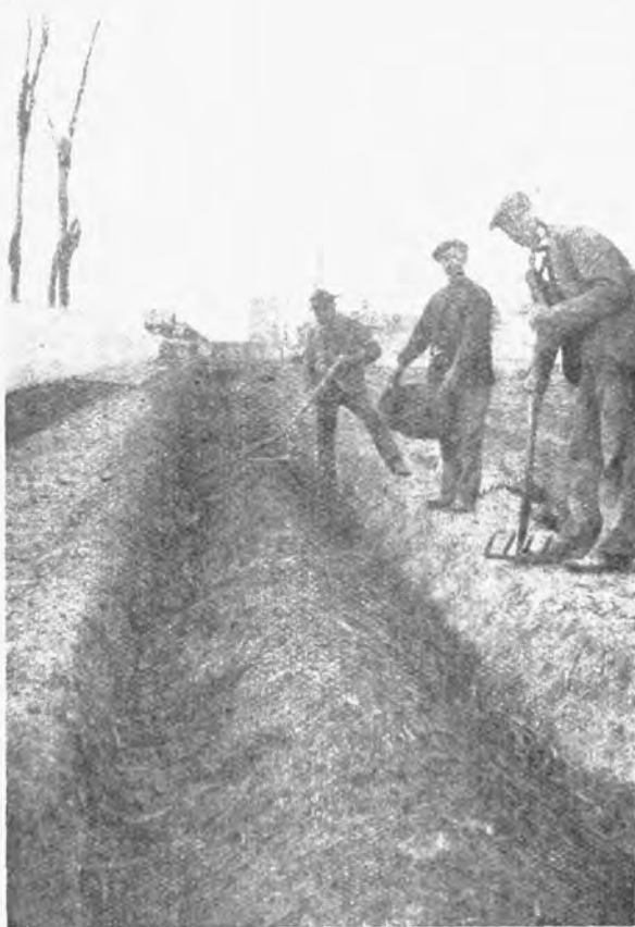
Fig. 25.—Excavada la zanja, con profundidad variable y una anchura máxima de 1,50 m., se amontona a lo largo de ella el estiércol de cuadra de la cama para que inicie su fermentación
