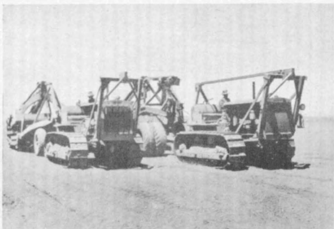
Las obras de preparación de tierras para el riego en gran escala se realizan empleando maquinaria pesada adecuada. (Fot. Bureau of Reclamation EE. UU.—1947.)
