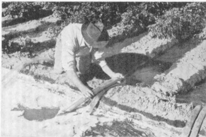
Un curioso método de control del caudal de agua utilizado por surco.
