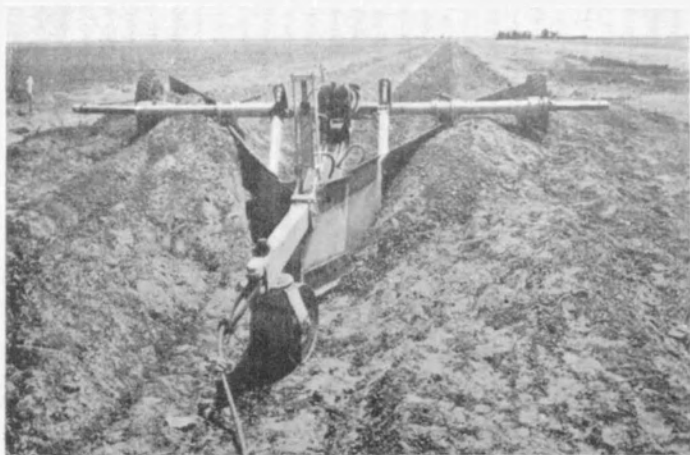
Potentes abrezanjas que se utilizan en la construcción de las redes de riego y desagües.
