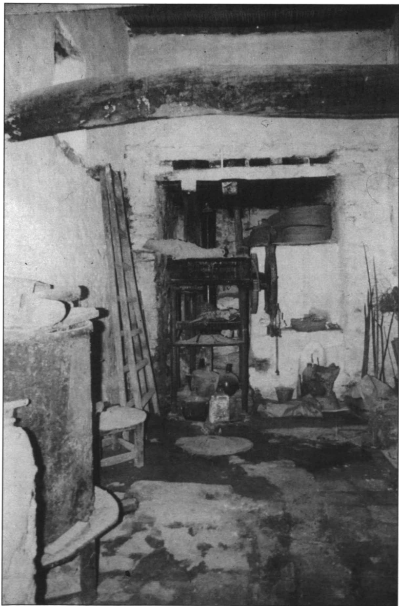
Fig. 7 Interior de un molino aceitero. La prensa de volante se ubica en el emplazamiento anterior de una prensa de viga. Parauta (Málaga).
