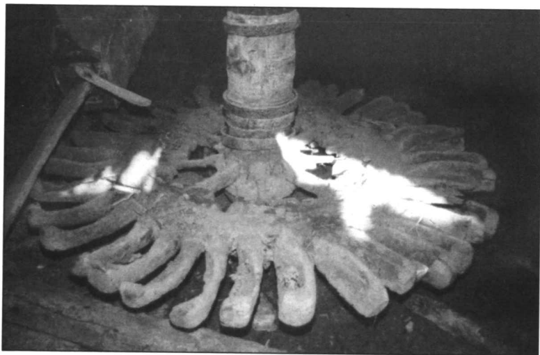
Fig. 1 Rodezno de molino hidráulico harinero.
