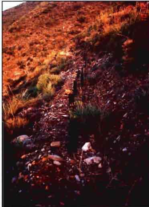
Repoblación forestal con subsolado lineal sobre terrenos de erial a pastos de gran pendiente. Preparación con un solo pase de ripper.
