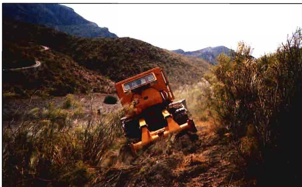
Preparación mecánica del terreno con Fiat Allis. Subsulado lineal con un ripper sobre terreno de retamar.
