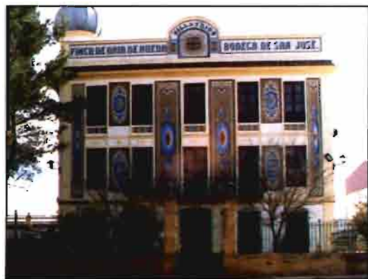
La construcción del edificio de Torre Oria llama la atención.
