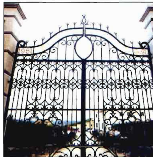
Entrada al hermoso edificio sede de Agro de Bazán.
