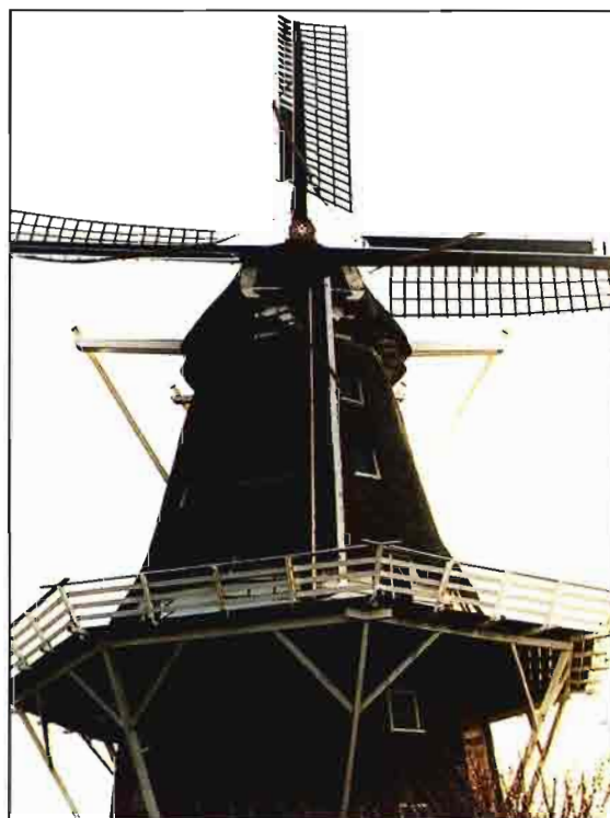
Fig. 1.- Molino holandés del siglo XVI empleado para desaguar los polders (por cortesía de F. Avia).
