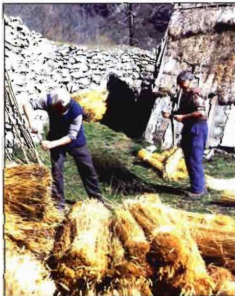
Para su restauración se utiliza paja de centeno.
