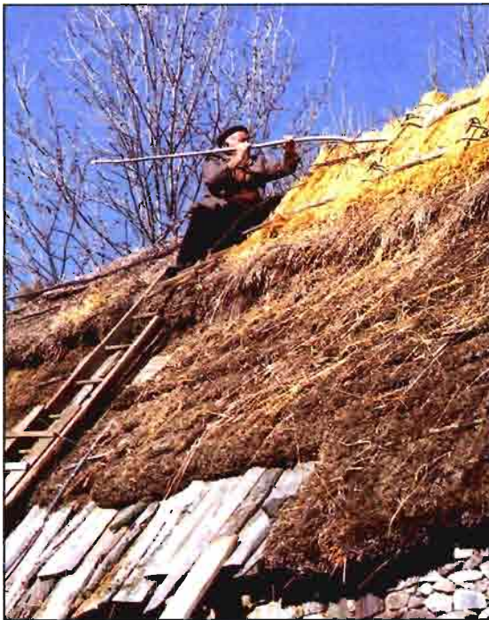
La orientación de los fajos de paja de la "capellera" está en sentido contrario al resto del tejado.
