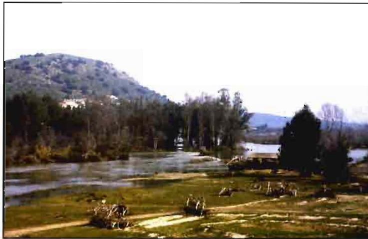
Los daños ocasionados en el campo por las inundaciones han sido muy importantes.
