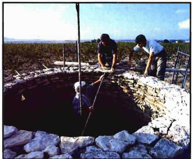
Manolo va manteniendo con la caña la distancia de colocación de las piedras.
