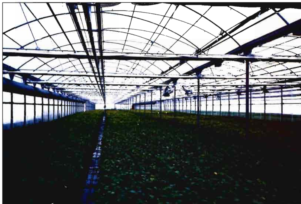
Viarsa dispone de unas instalaciones adecuadas para conseguir una alta producción de planta forestal.
