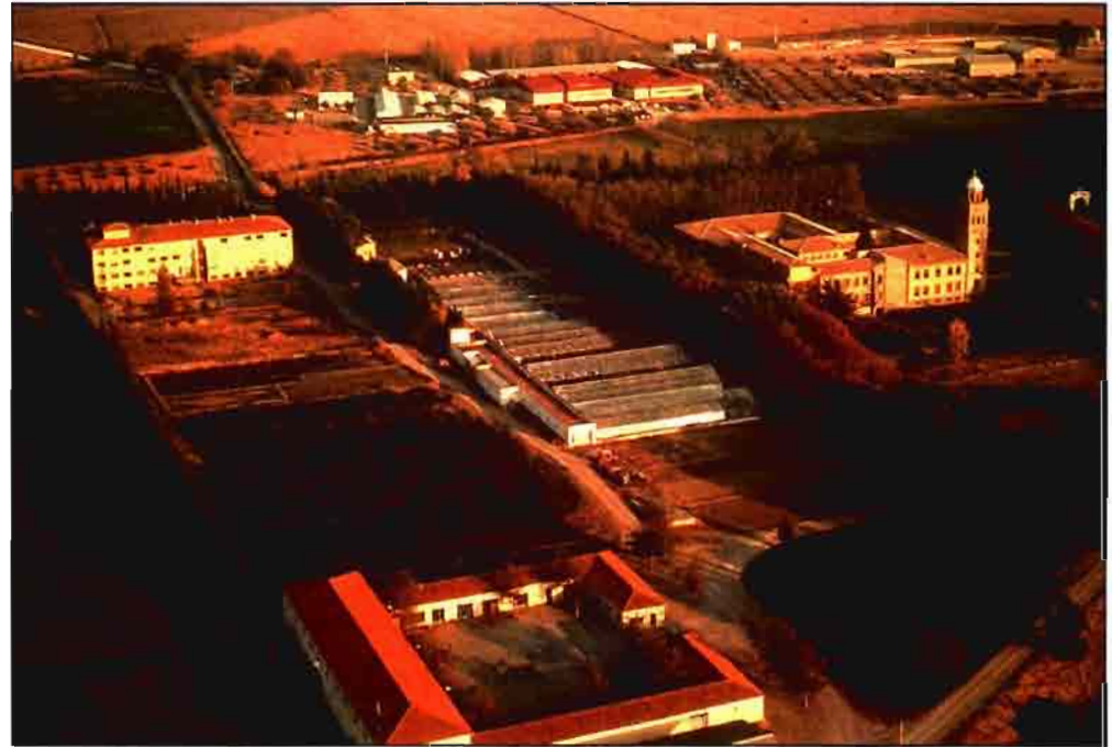
Vista general del «Campus Aula Dei».
