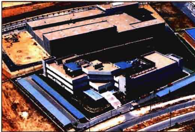
Edificio central de Rural Servicios Informáticos.
