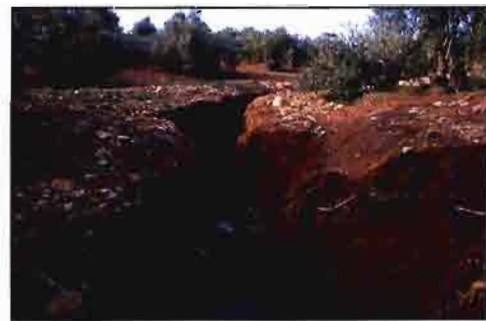
La acumulación de agua de escorrentía en las vaguadas deja al descubierto muchas raíces y dificulta el tránsito posterior.
