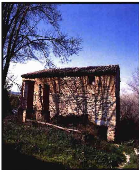
El hombre ha sabido utilizar la fuerza del agua de los ríos en beneficio propio y para múltiples usos. Por debajo del edificio pasa el cauce del agua que mueve la turbina.
