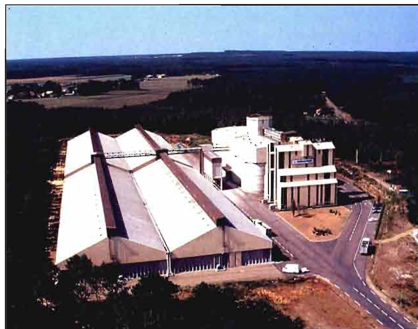
Arriba, almacenes-silos de Maisadour.
