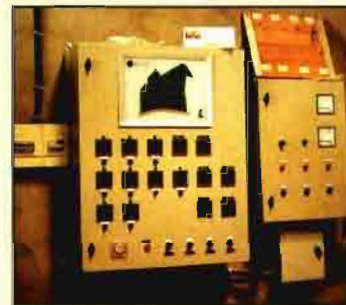
Sistema y cuadro de mandos para la fertirrigación en La Palmosa.
