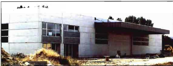
Nueva nave de ensayos de abonadoras y sembradoras de Palencia.
