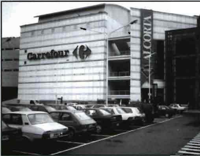
Paseo Alcorta. Hipermercado asociado a Centro Comercial, ubicado dentro de la trama urbana.
