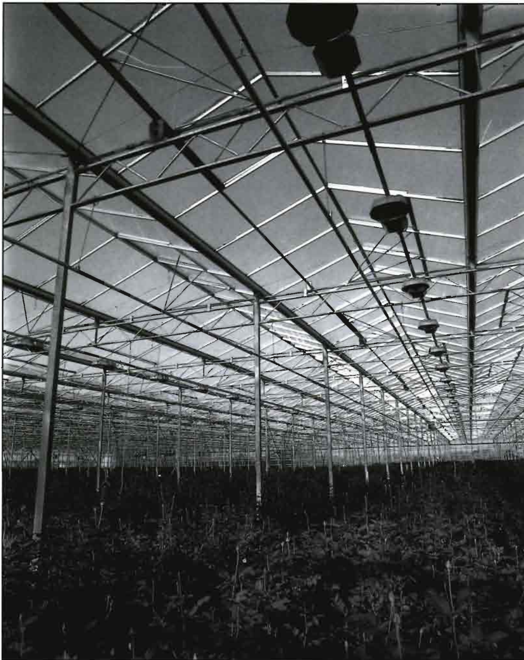
Gracias a la aplicación de la más moderna tecnología es posible el control ambiental completo en los invernaderos de cristal, con lo que se consigue prolongar la época de cultivo y mejorar la calidad de producción.
