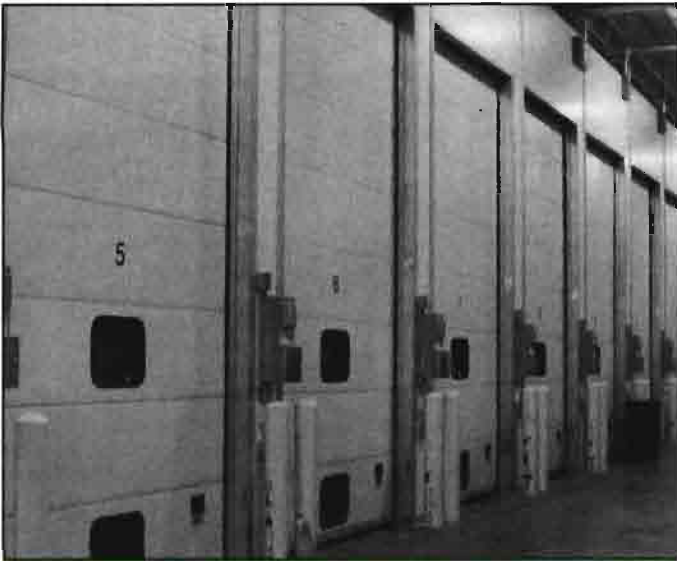
Instalación de desverdización de plátano en Wisconsin, E.E.U.U., que aporta un mejor control del proceso y un incremento en la eficiencia de la operación.
