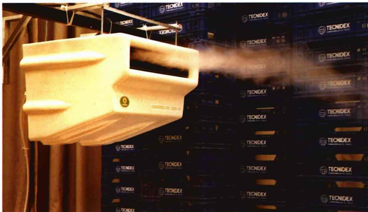
Control-Tec 2001 H, humidificador diseñado para proveer a las cámaras con vapor de agua de 100%, sin mojar los productos almacenados. El vapor de agua es producido de modo que el agua se transforma en una niebla ultrafina que es repartida por todo el recinto al ser impulsada por el ventilador incorporado al equipo.
