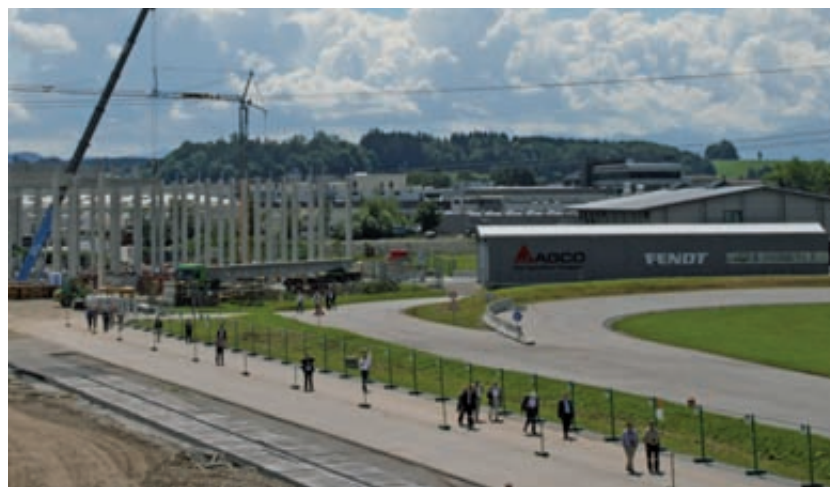
Durante la visita a la planta de Marktoberdorf el pasado mes de junio pudimos comprobar el estado de las obras de los nuevos pabellones de montaje, incluidos en el proyecto Fendt Ahead 2 .
