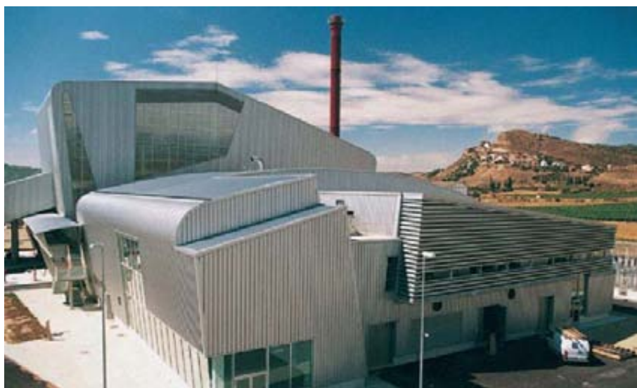
Planta de producción eléctrica con biomasa en Sangüesa. Foto: Acciona Energía.
