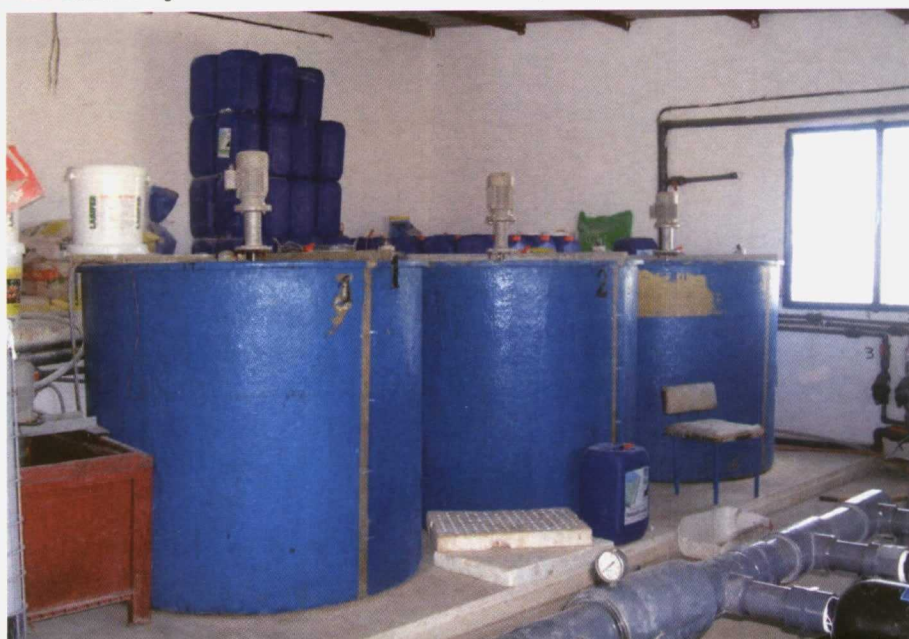
Foto 2. Cabezal de riego. Tres disoluciones concentradas: macronutrientes, calcio y micronutrientes.
