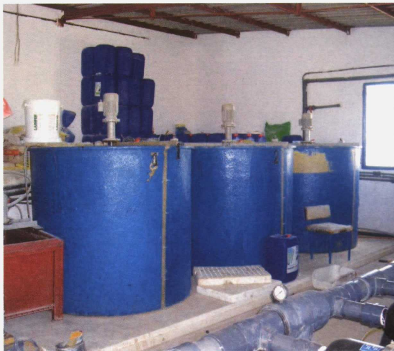
Cabezal de riego. Tres depósitos de disoluciones concentradas para calcio, resto de macronutrientes y micronutrientes.
