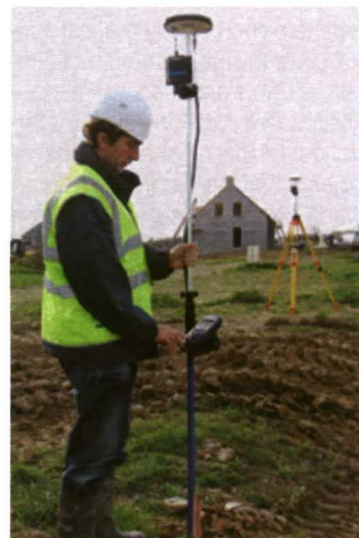
Foto 4. Marcado de líneas de la plantación mediante sistemas de posicionamiento en topografía. Sistema GPS con base de corrección RTK (al fondo de la imagen). Fuente: http://www.geosistemassrl.com.ar/index.php
