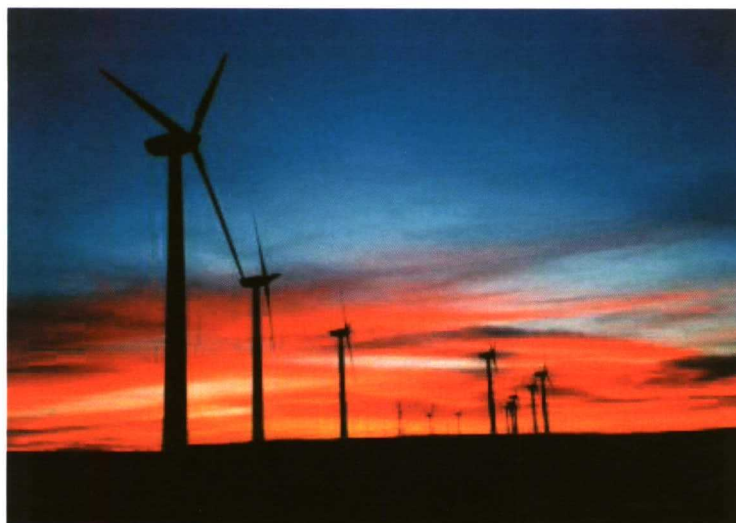
Parque eólico en Teruel de 9,24 MW.
