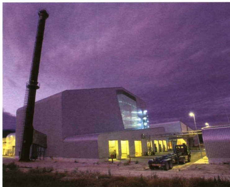
Planta de biomasa de Acciona Energía en Sangüesa, Navarra.
