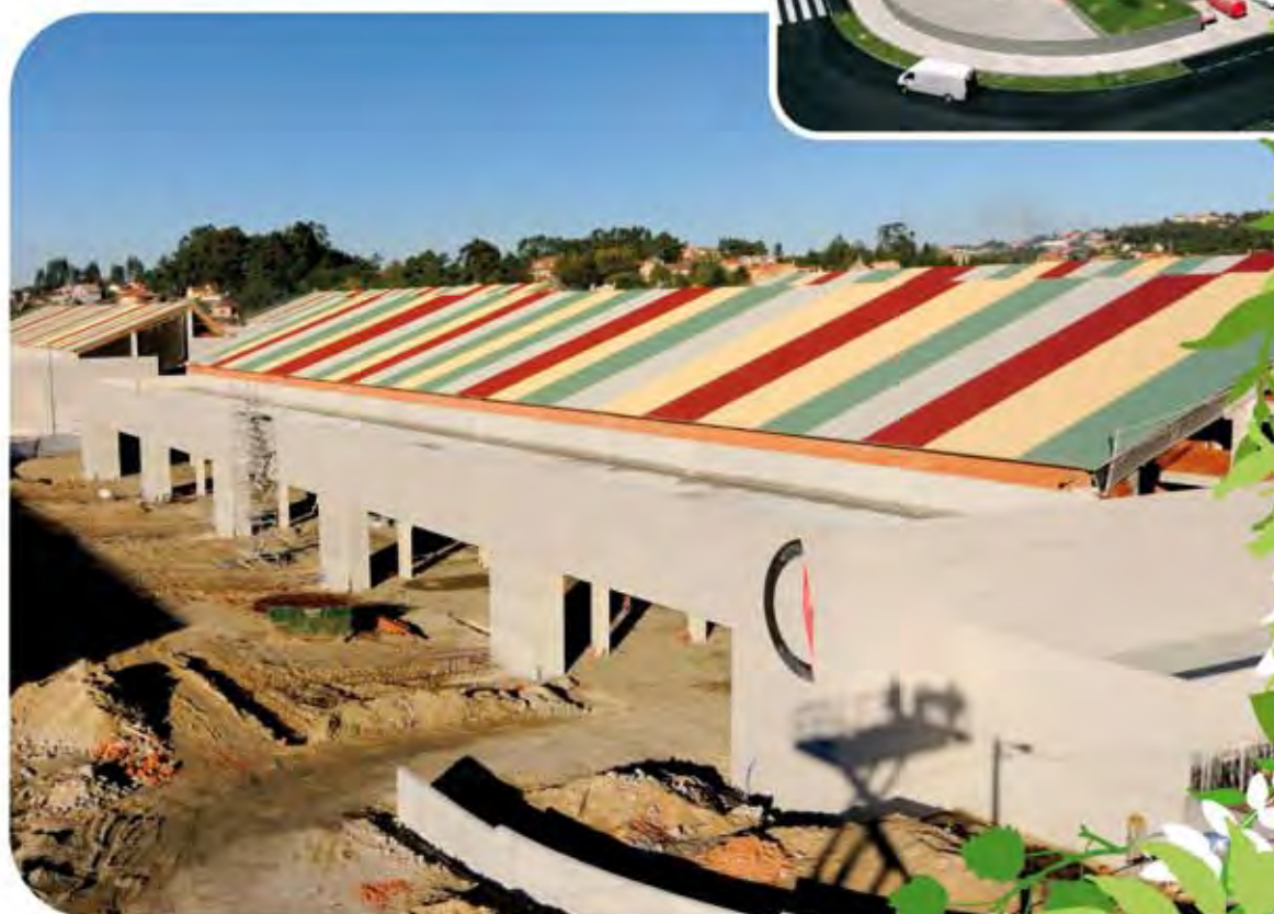
Remate das obras febreiro 2011
