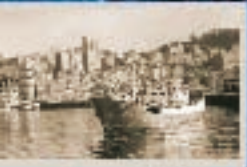
El sistema de seguridad para instalaciones portuarias.
