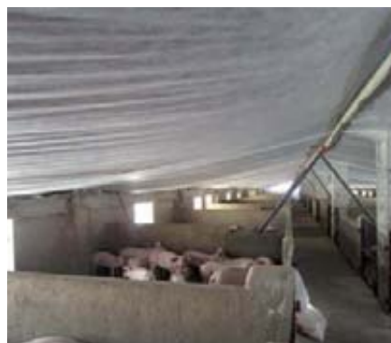
Foto 1. Manta térmica instalada en una nave.
