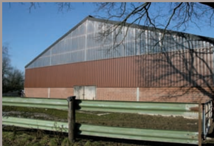
Fachada de la explotación.
