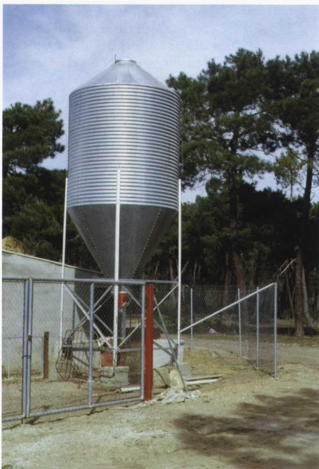
Acceso al silo desde el exterior.
