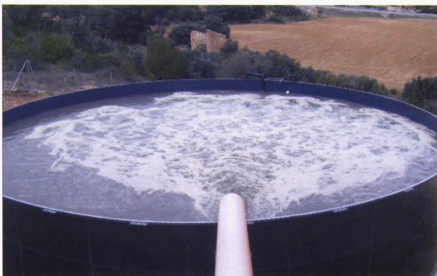
Foto 3. Depósito de almacenamiento intermedio lleno de purín.
