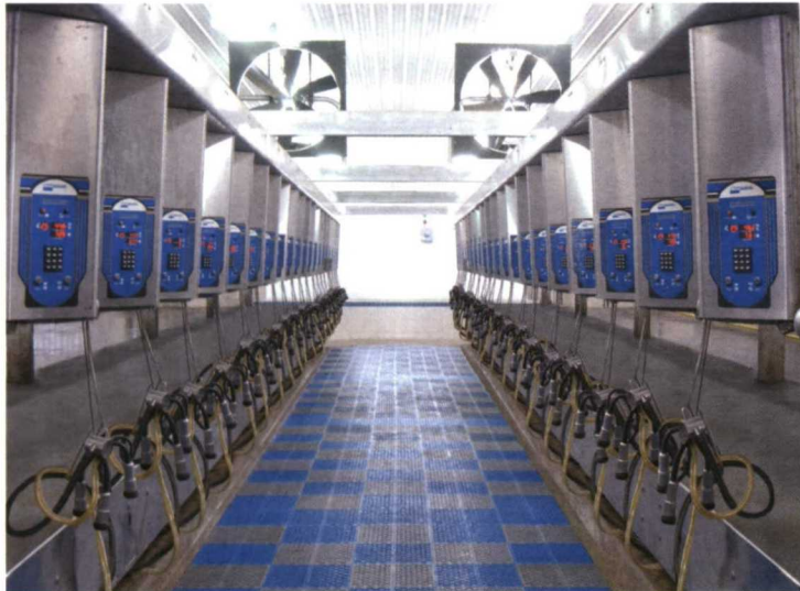
Foto 4. Instalación de ventiladores y plaquetas de suelo confort en la sala de ordeño.
