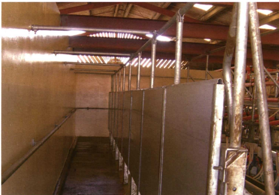
Foto 7. Pasillo de retorno.
