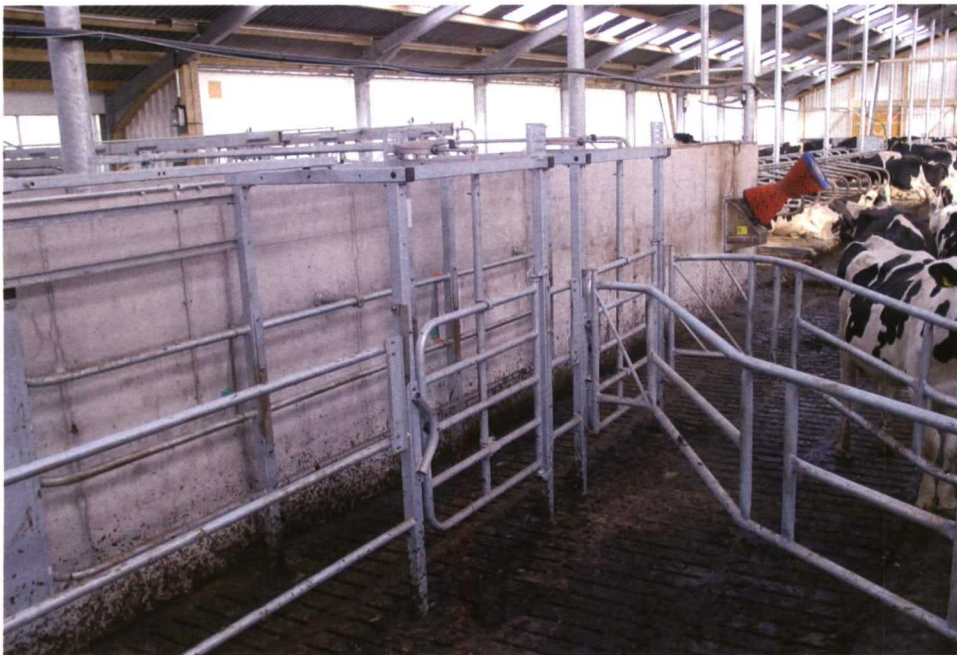
Foto 8. Puerta de triaje en pasillo de retorno.
