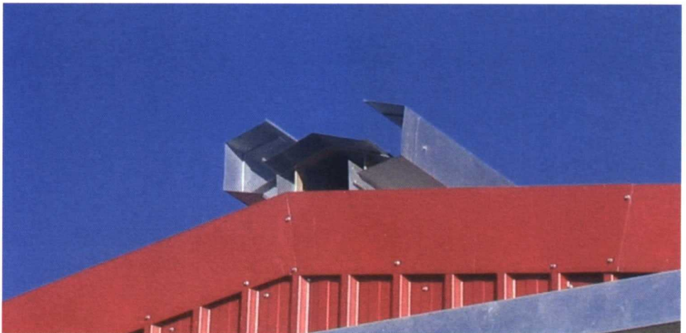
Figura 3. Cumbre para ventilación estática vertical.
