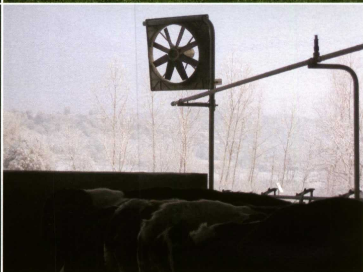
De arriba hacia abajo y de derecha a izquierda: Foto 6. Muro lateral de 2,5 m de hormigón y grandes aberturas fijas. Foto 7. Protección natural con árboles. Evitamos la radiación solar y nos protege de los vientos. Foto 8. Foto 9. Ventilador pequeño. Suelen ir muy revolucionados y hacen bastante ruido.
