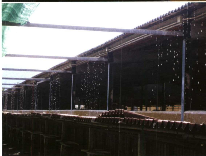
De arriba hacia abajo y de derecha a izquierda: Foto 2. Carenado semiabierto de ventilación. Foto 3. Otro tipo de carenado de ventilación. Foto 4. Sistema de aspersión en el tejado para refrescar el ambiente. Foto 5. Ventilación lateral, tejado con aislante en zonas de clima frío.
