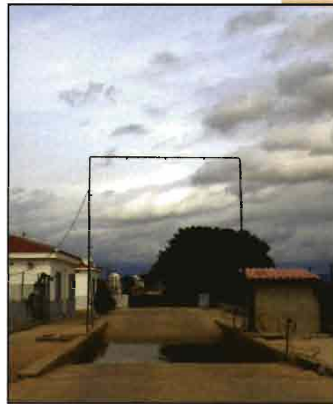
Foto 3: Camino de servicio a los silos. Fuente: los autores.
