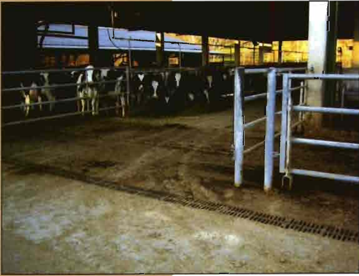
Foto 5.- Zona de paso diario del carro mezclador de alimentos coexistiendo con el mecanismo de recogida de estiércol.
