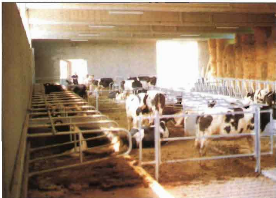
9.- Establo donde se ha hecho la experiencia (obsérvese en primer plano el particular divisor adoptado, que al estar anclado en la pared elimina los problemas debidos a la corrosión).
