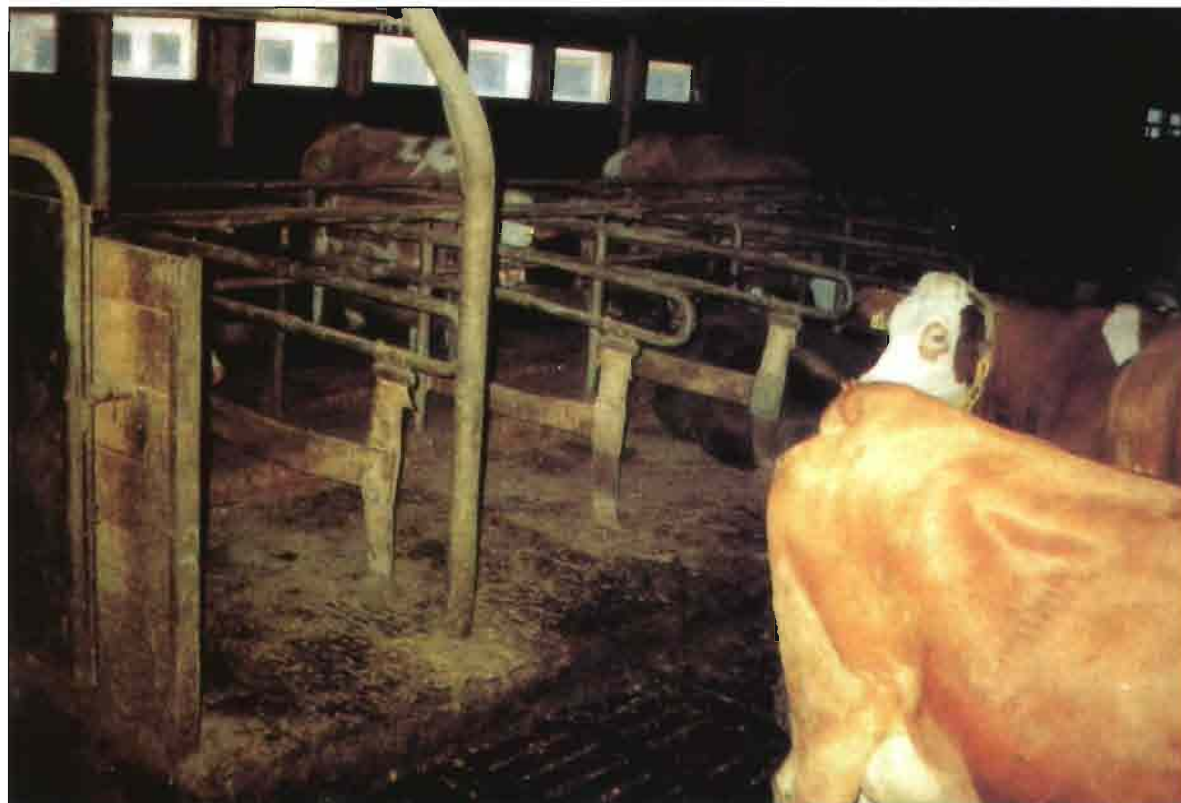
5.- Divisores de metal integrados con cintas elásticas (obsérvese el uso de colchones sintéticos monocama como pavimentación de los cubículos).
