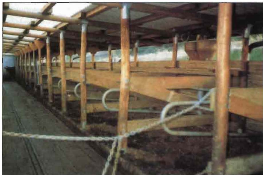
6.- Tipo en "cow kennel", con estructura de madera (obsérvese la original solución que alterna el uso de divisores de madera y de metal).
