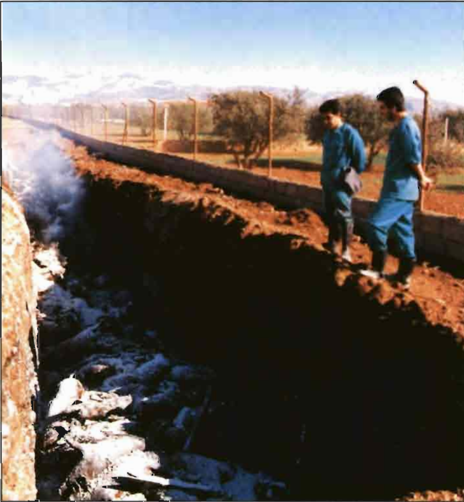
Detalle de la fosa donde se enterraron los cerdos en el foco granadino. Obsérvese que entre la superficie del terreno y el último cerdo enterrado hay más de 1,5 m.
