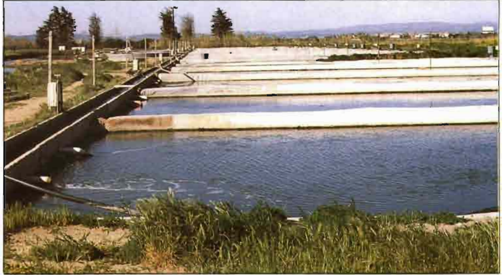
Canalillo de alimentación en cemento para estanques en tierra revestidos con tela de material plástico Piscifactoría "La Rosa s.r.l.", Las Salinas de Orbetello (GR).
