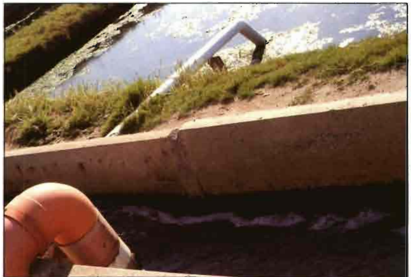
Canal de alimentación en cemento y tubería de derivación en P.V.C. - Piscifactoría "Nausica Aurea s.r.l.", Il Fossone, Albinia (GR).
