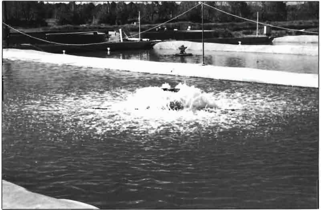
Estancos de cría en tierra revestidos con tela de material plástico - Piscifactoría "La Rosa s.r.l.", Las Salinas de Orbetello (GR).
